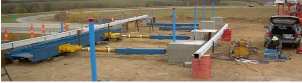
Fig: Horizontal load test on piles
